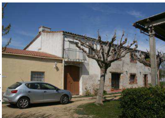
Façana principal desde la dreta 2009
