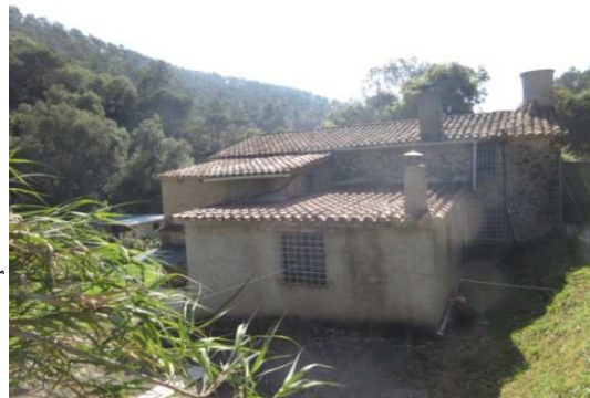
Façana lateral nord
