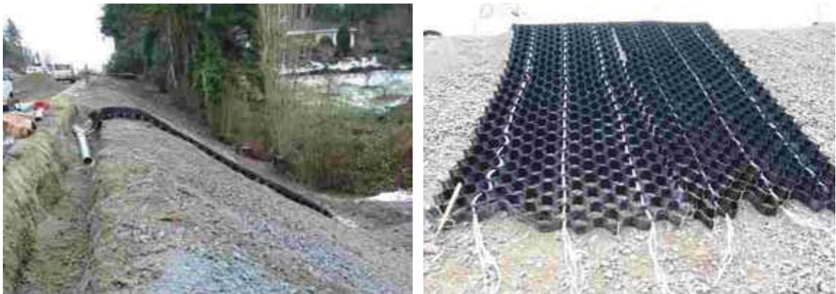
Imatges de la instal·lació de geocel·les en una llera
