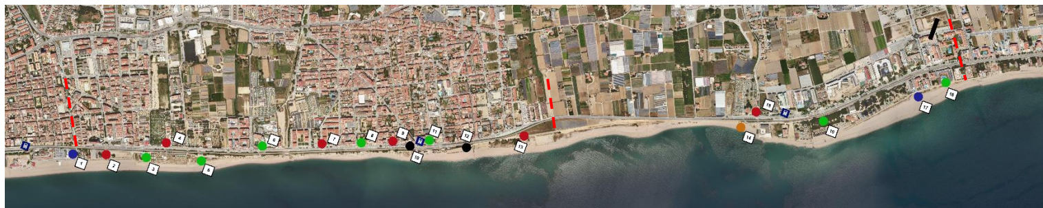
Il·lustració 24: Passos existents travessant la línia del tren, que comuniquen l'interior amb la platja. (Veure plànol I-09)
